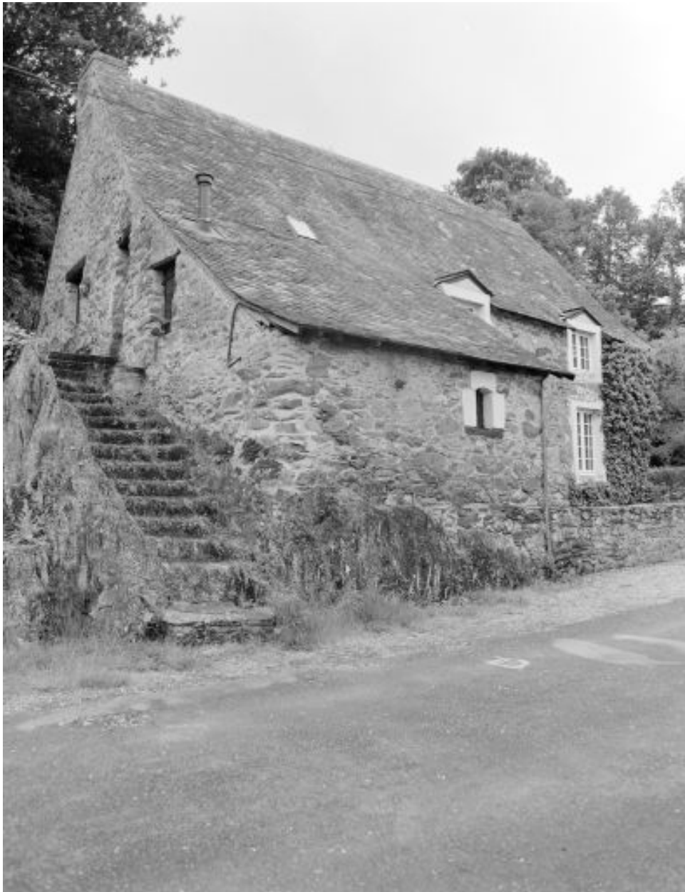
La maison de meunier. Vue depuis le nord-ouest.
