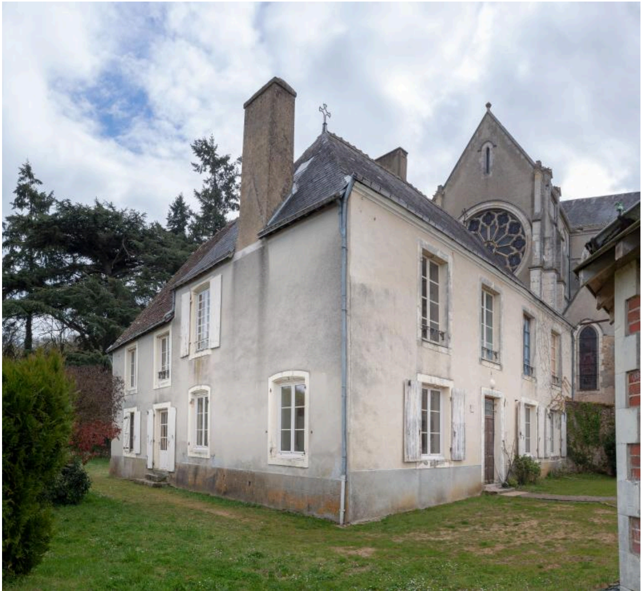
Les façades principale et latérale.
