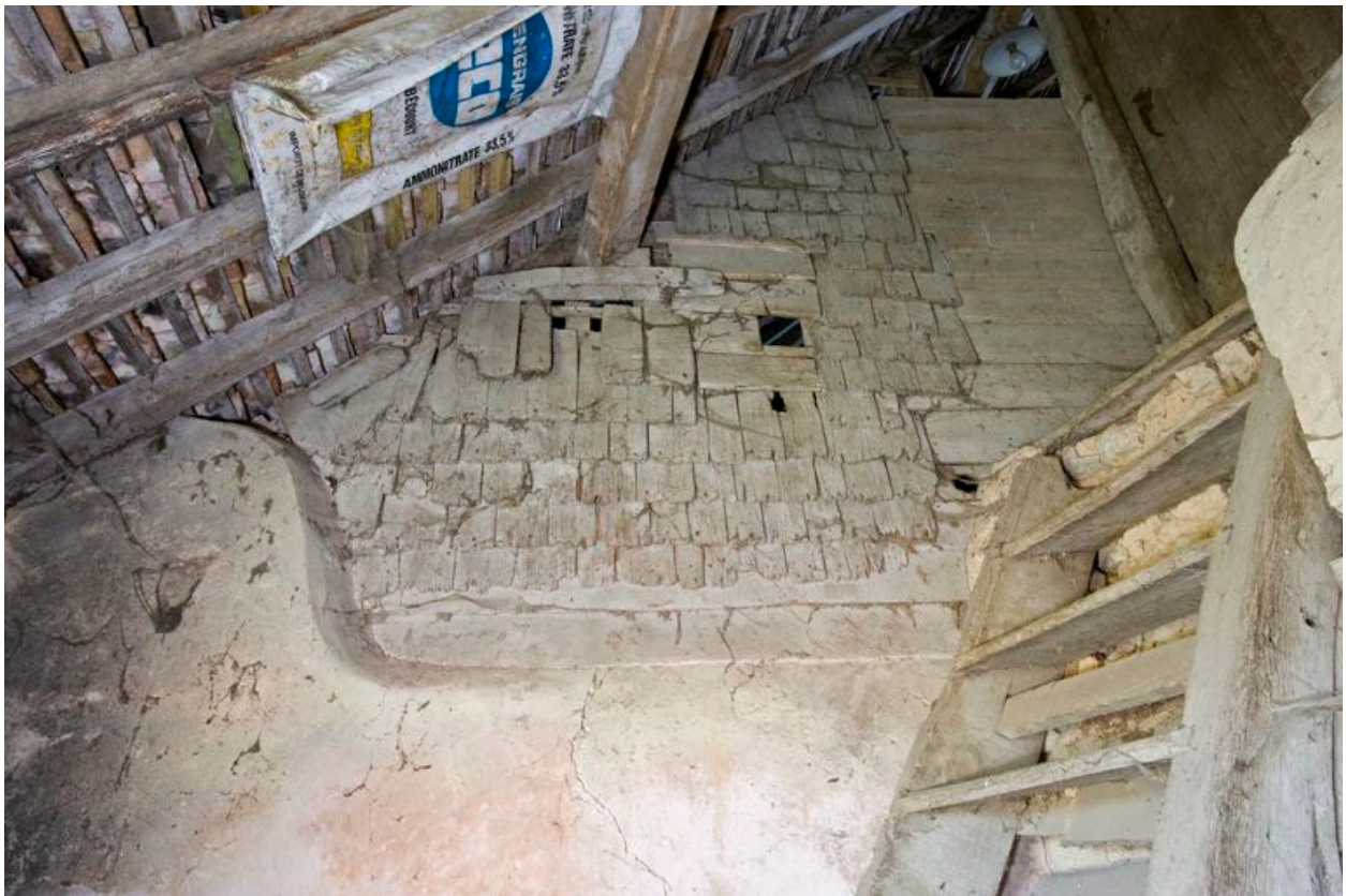
Logis, essentage de bardeaux de l'ancien pignon sud du logis.
