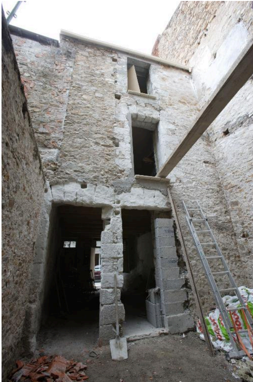
Maison n° 12 : la façade postérieure du premier bâtiment.
