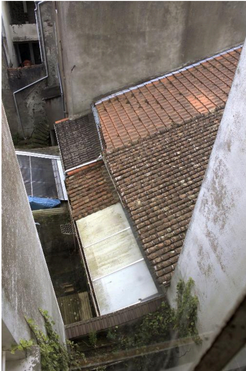
Vue partielle de la toiture depuis l'escalier de la maison n° 54.
