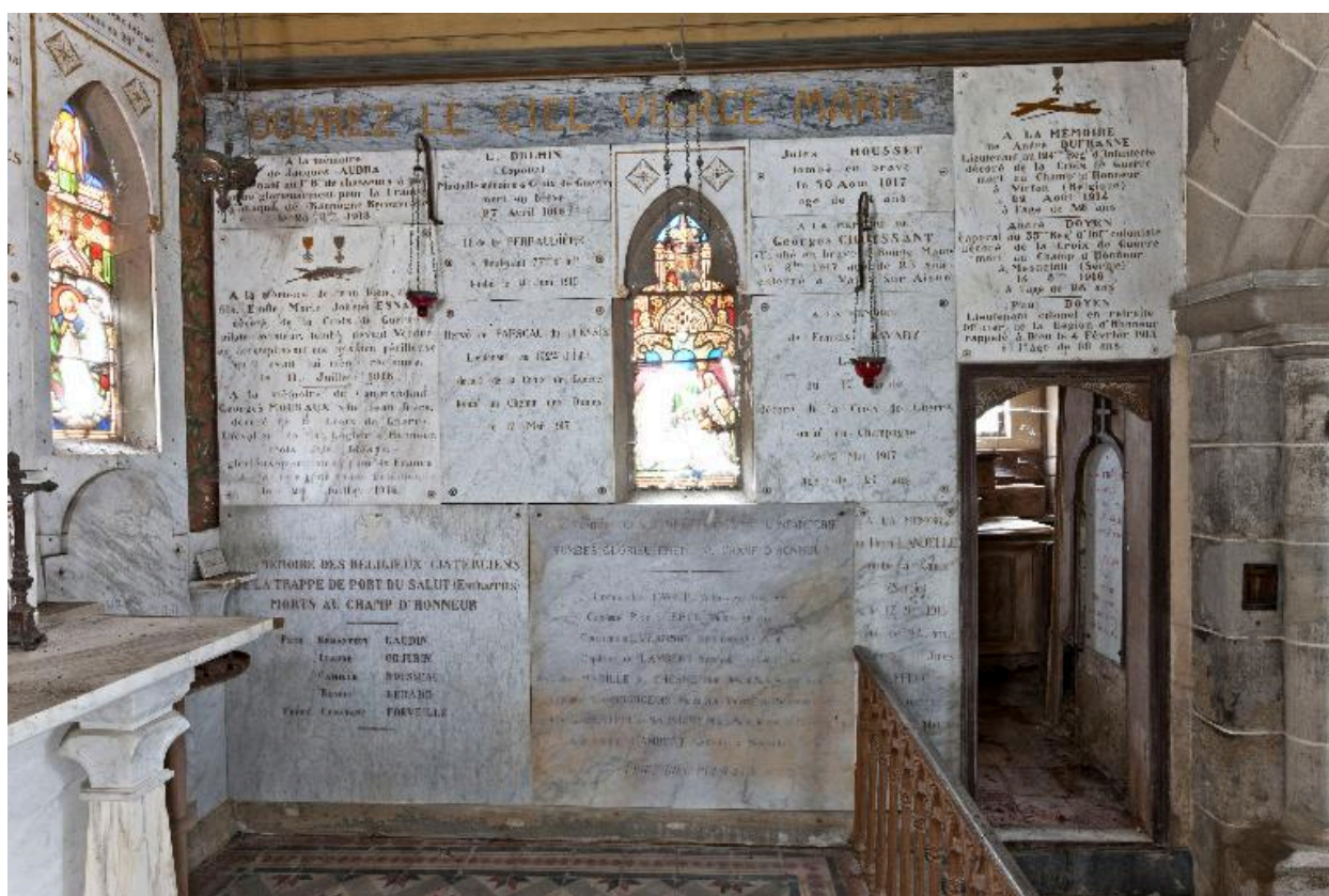
Chœur : vue d'ensemble des plaques commémoratives du mur sud.
