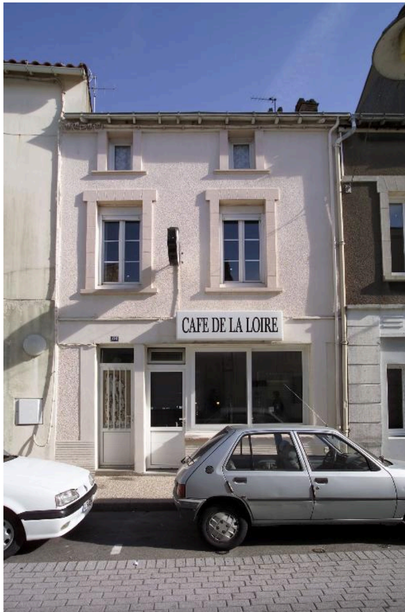
Vue de la façade n° 64 rue du Général-De-Gaulle.
