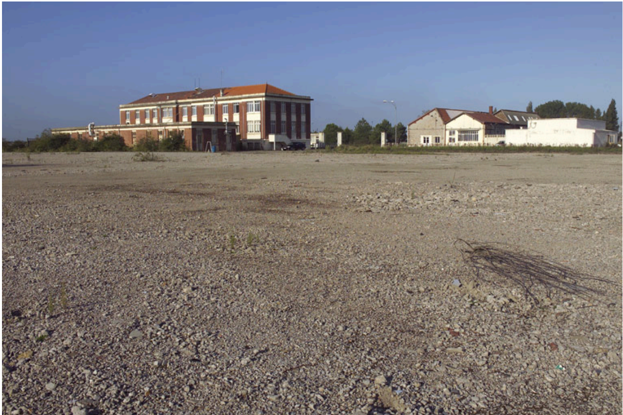
Vue générale des bâtiments subsistant sur le site en 2004, vue prise depuis l'amont.
