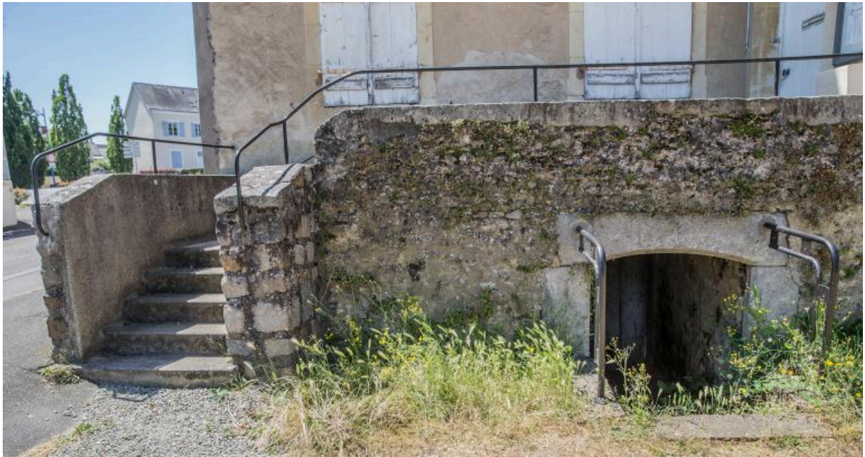
L'ancienne maison Métais, détail de l'entrée de cave, rue de la Gare.
