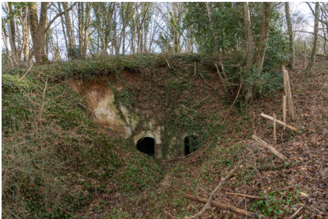
Celliers troglodytiques, près du chemin creux au-dessus de Vauboin.
