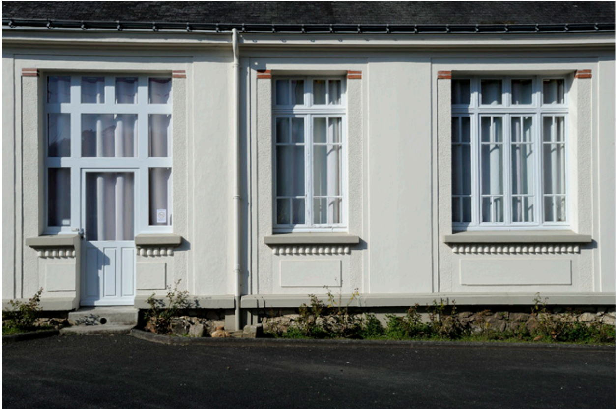
École : façade est, détail de trois baies (celle de gauche appartient à l'extension de 1957)
