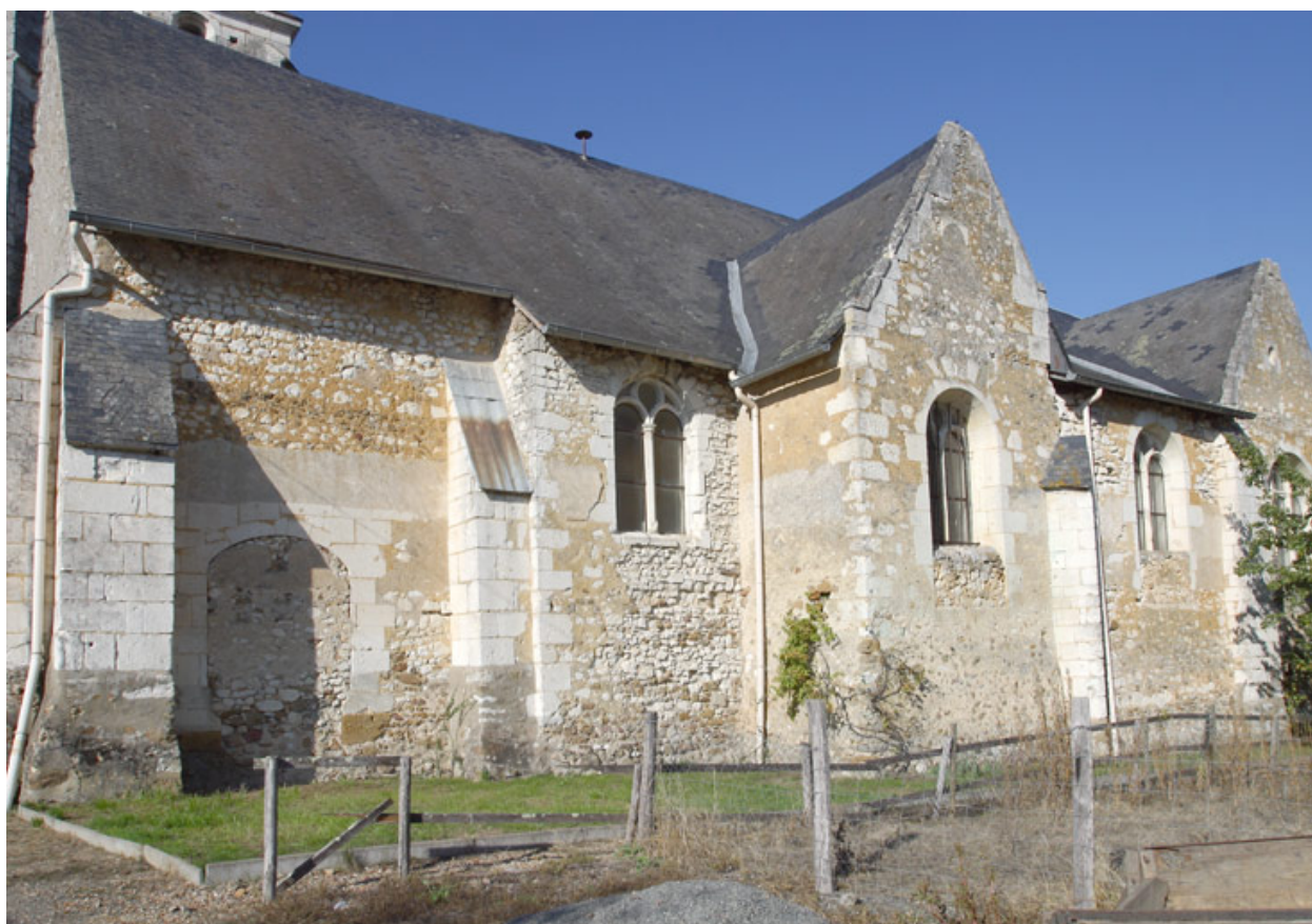
Nef, mur sud : enduit de la litre extérieure.
