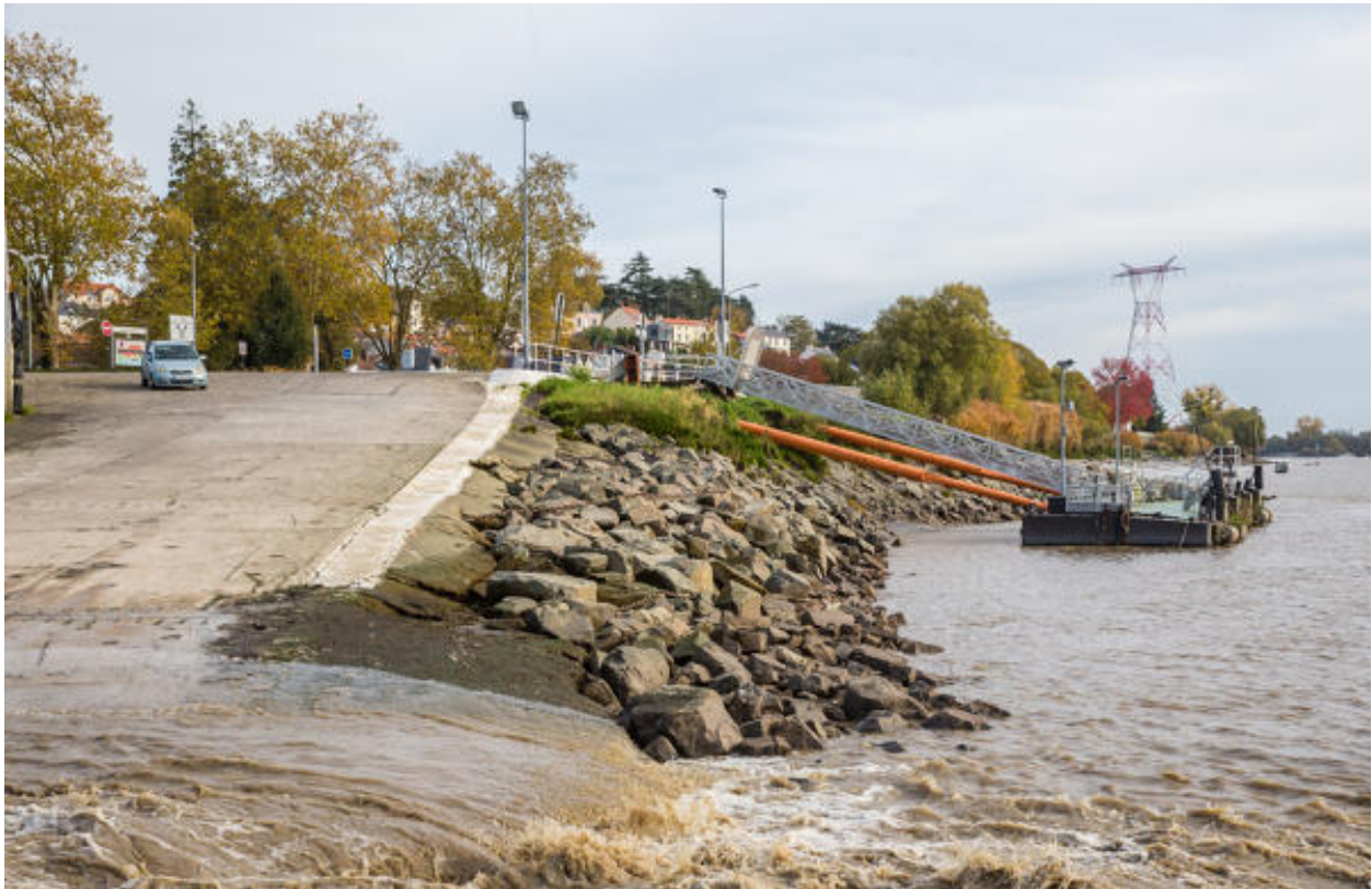
Cale aval et appontement de l'embarcadère de Basse-Indre.
