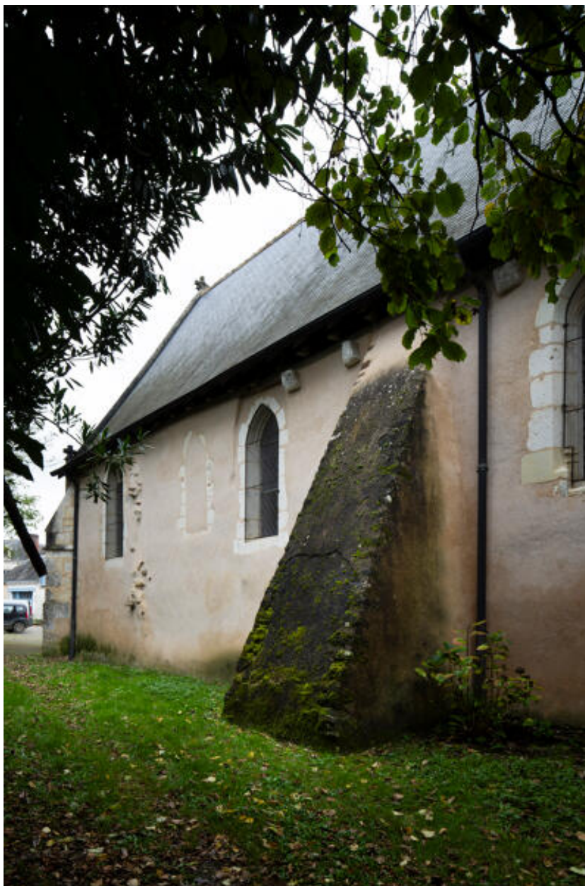
Mur extérieur de la nef côté sud.
