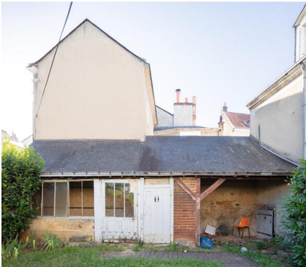
Vue de l'appentis dans le jardin de l'ancien presbytère.
