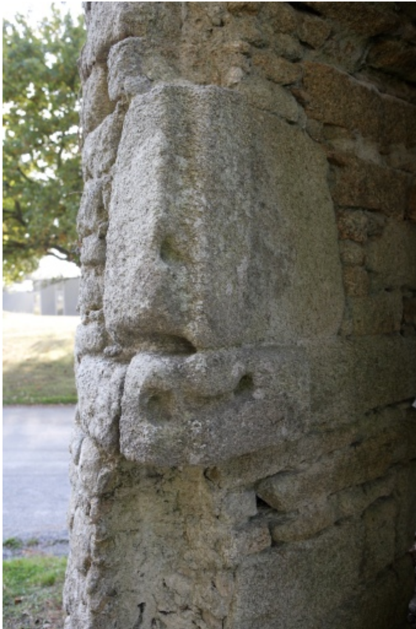
Porte d'accès à la cavité centrale de la tour ; détail du montant gauche.
