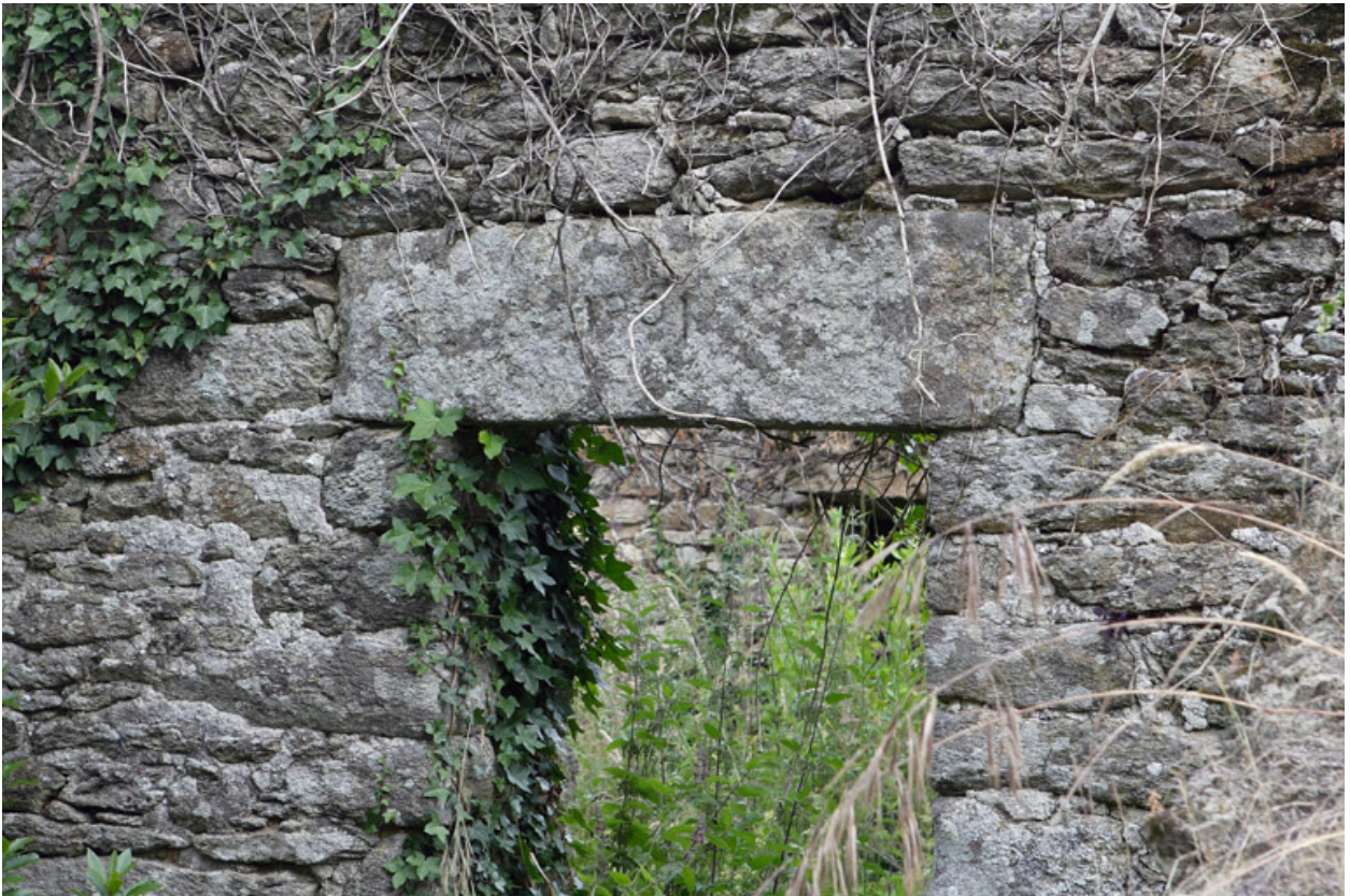
Détail du linteau de la porte daté 1761.
