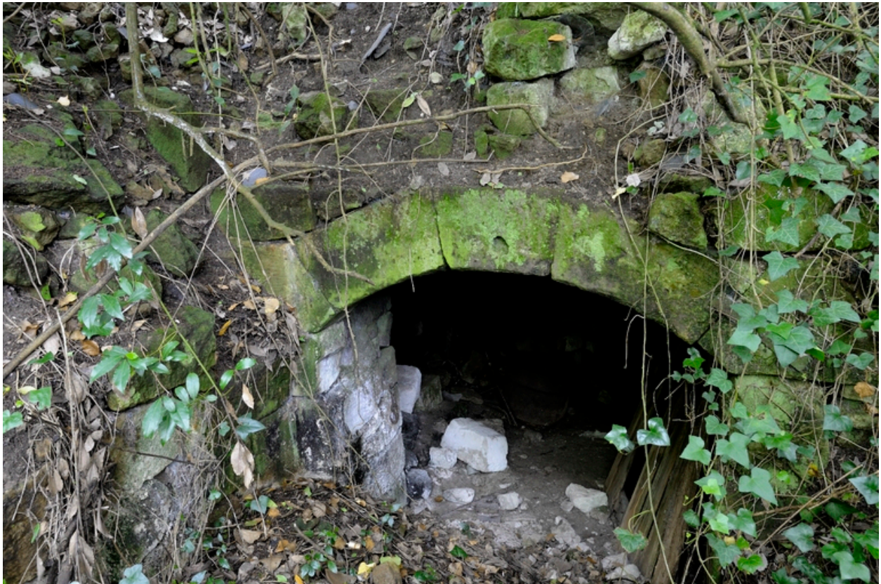
Douves, entrée d'une cave creusée dans le mur de contrescarpe.
