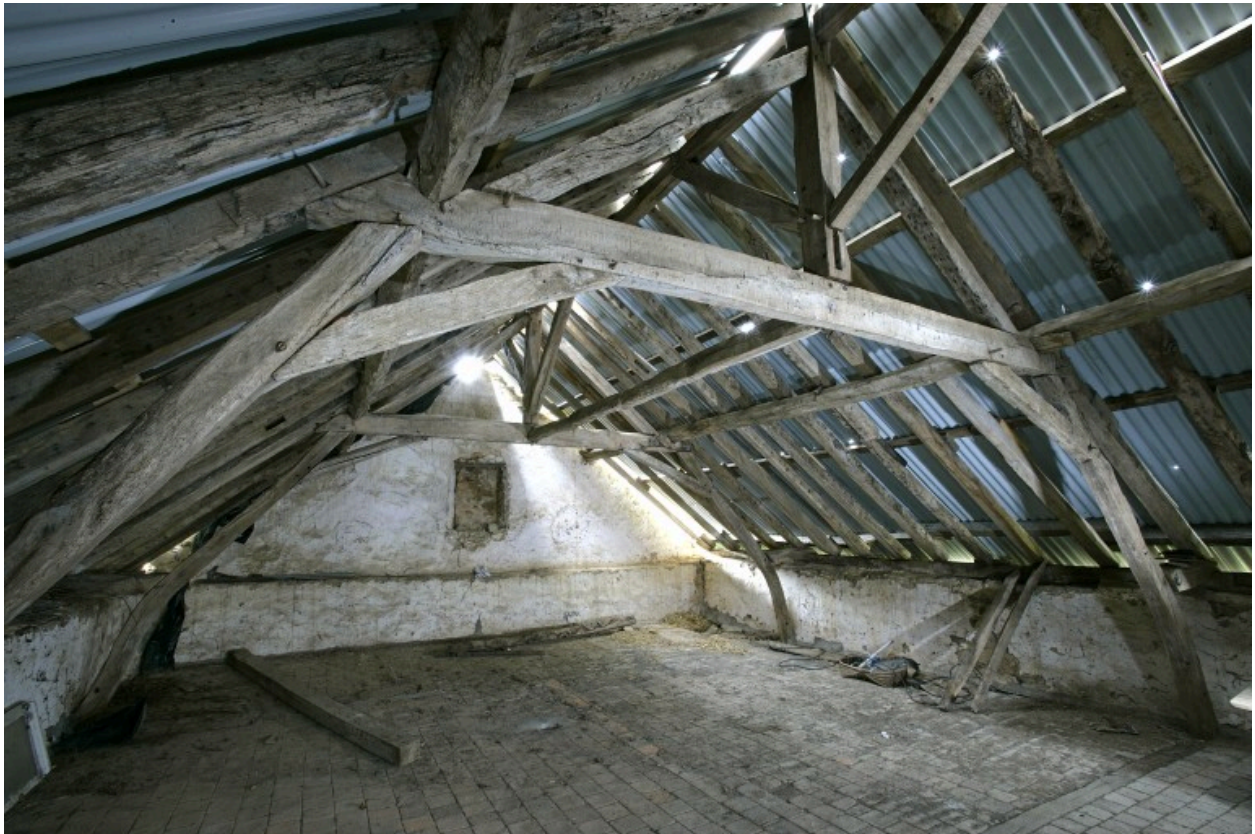
Le logis manorial, comble de la partie centrale : la charpente vue depuis le nord.
