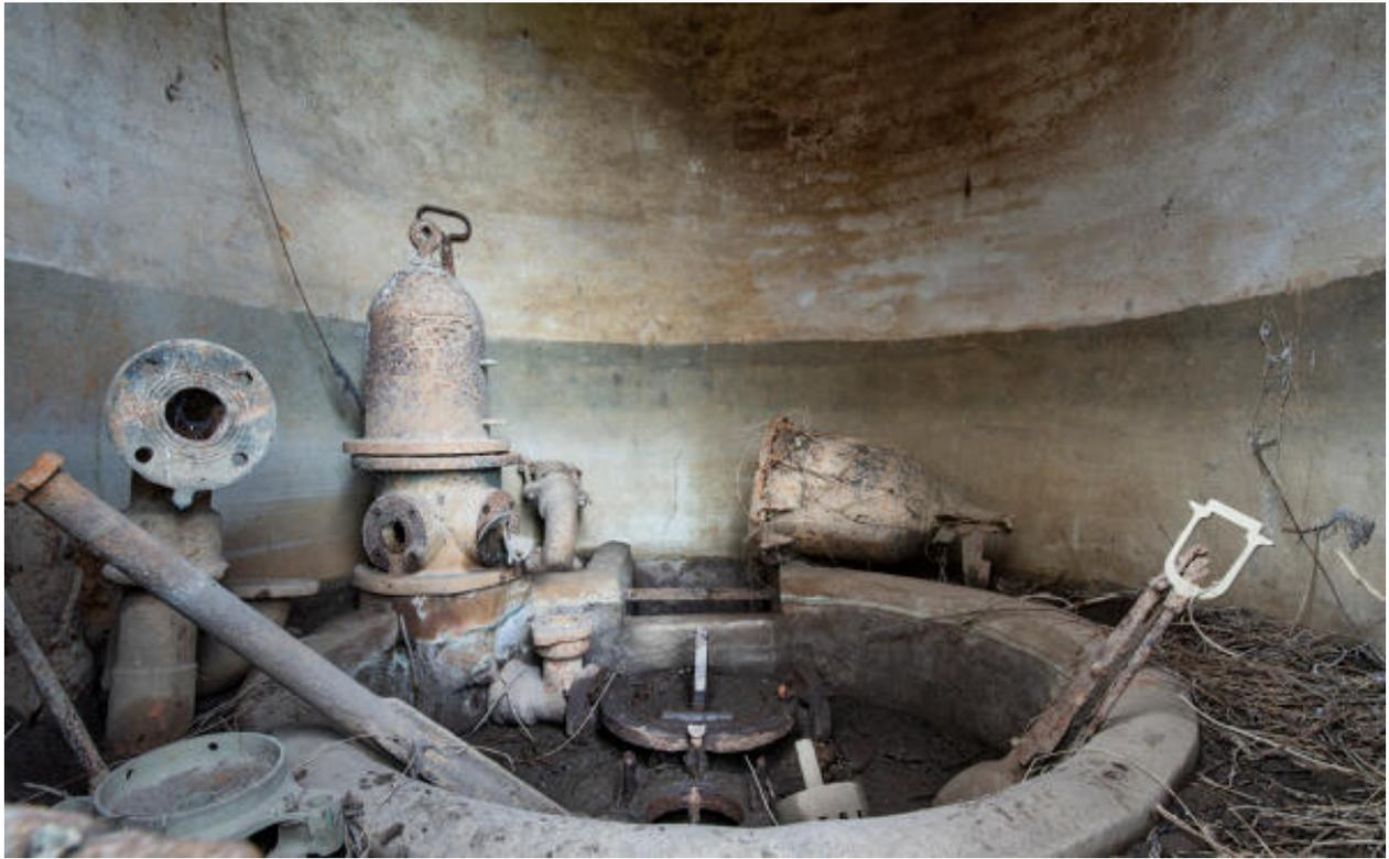
Vestige du bélier hydraulique modèle n° 01682 installé en 1902 par les établissements Bollée.
