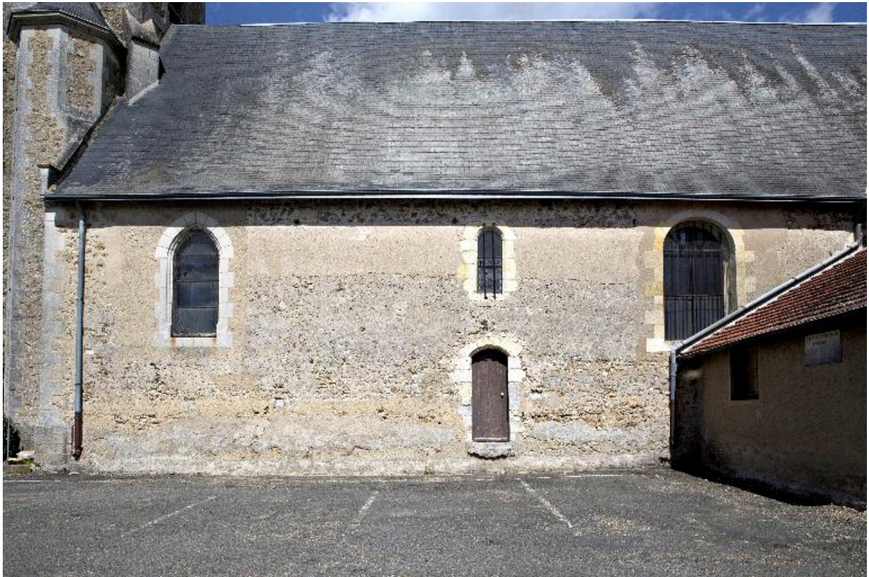
Mur sud de la nef.
