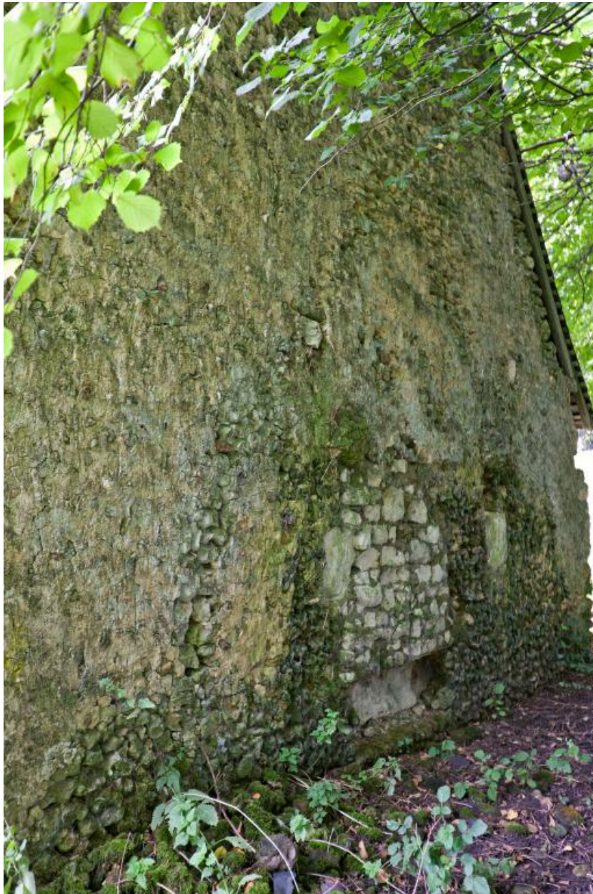
Mur-pignon ouest avec vestiges de la bouche du four à pain.
