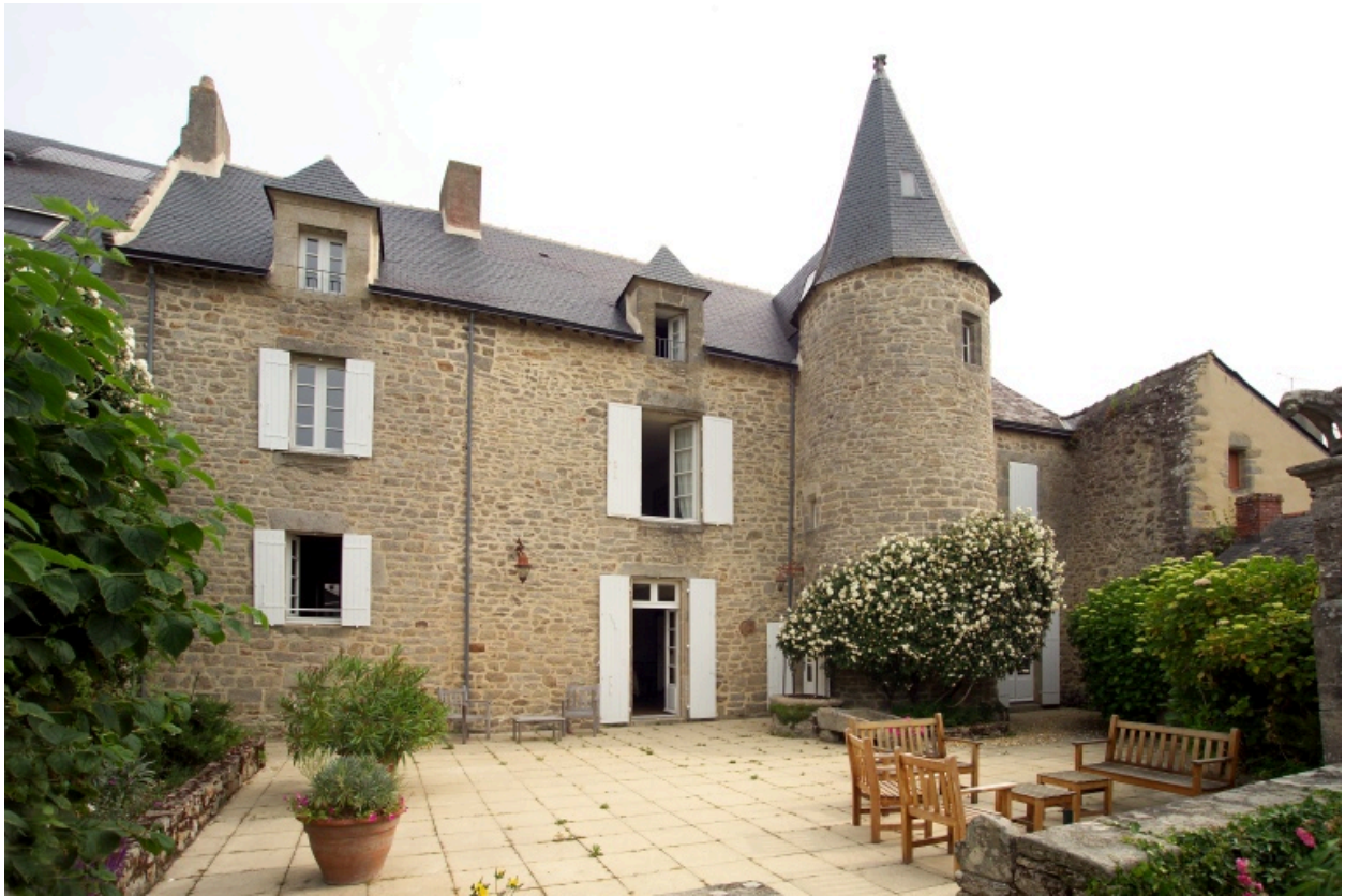
Vue de la façade postérieure au Sud.
