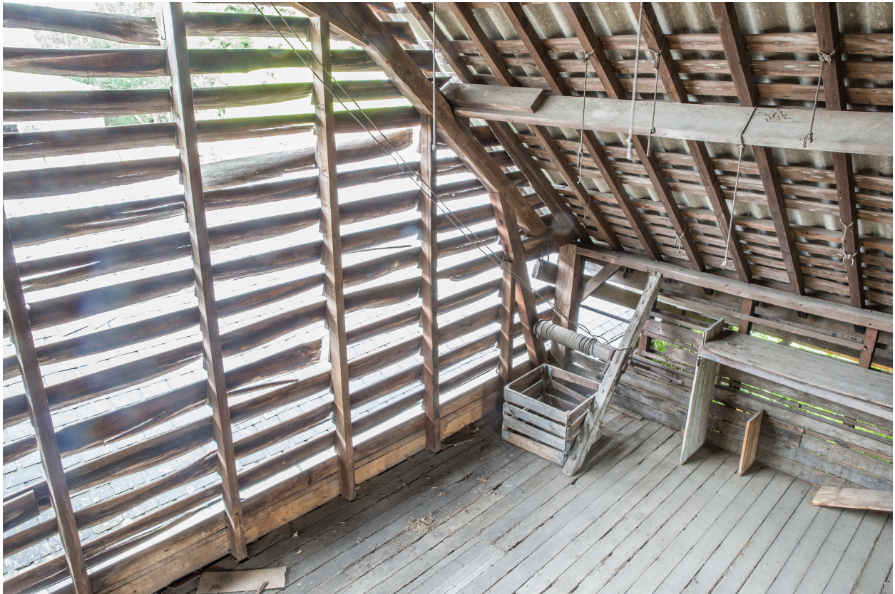
Un pignon du séchoir depuis le comble.
