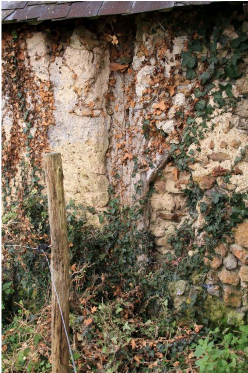
Vieille maison, mur goutterot nord : vestiges d'un pan de bois.
