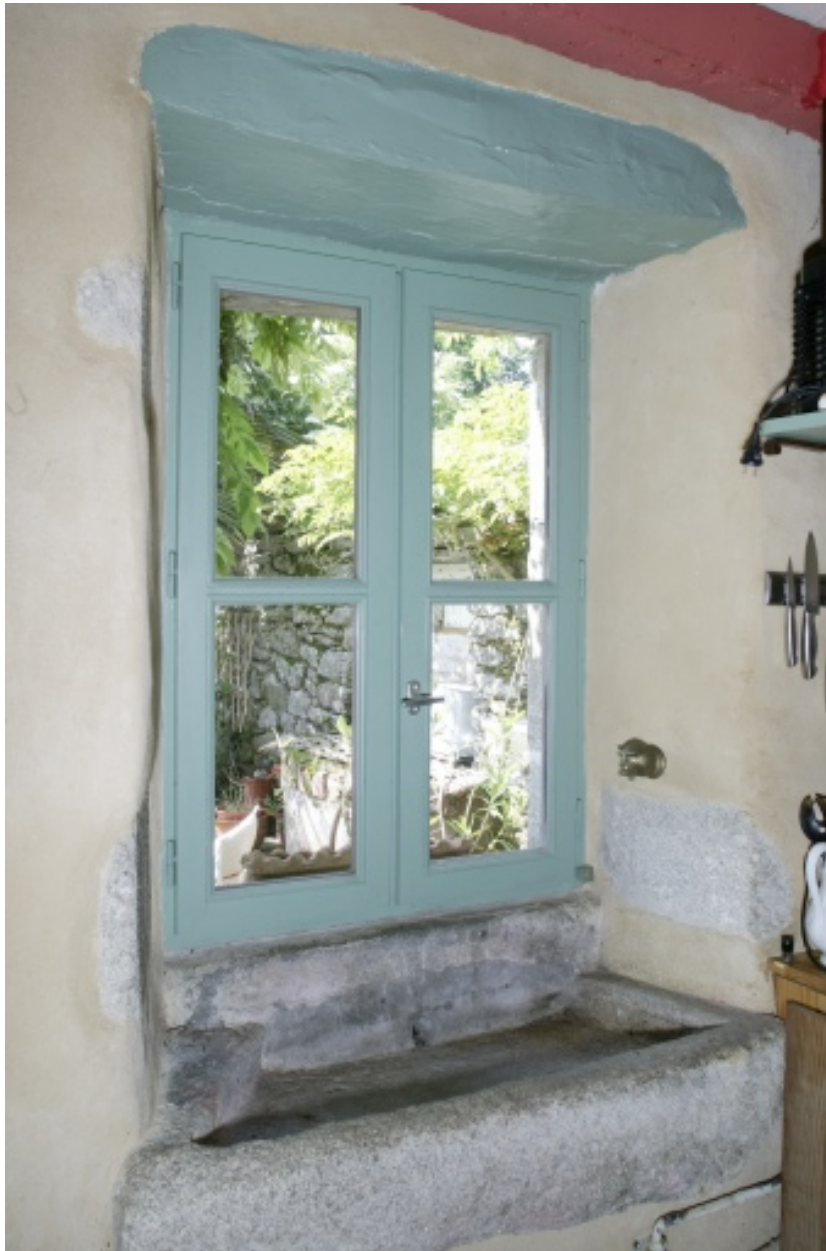
Évier en granite au rez-de-chaussée dans la partie sur jardin.
