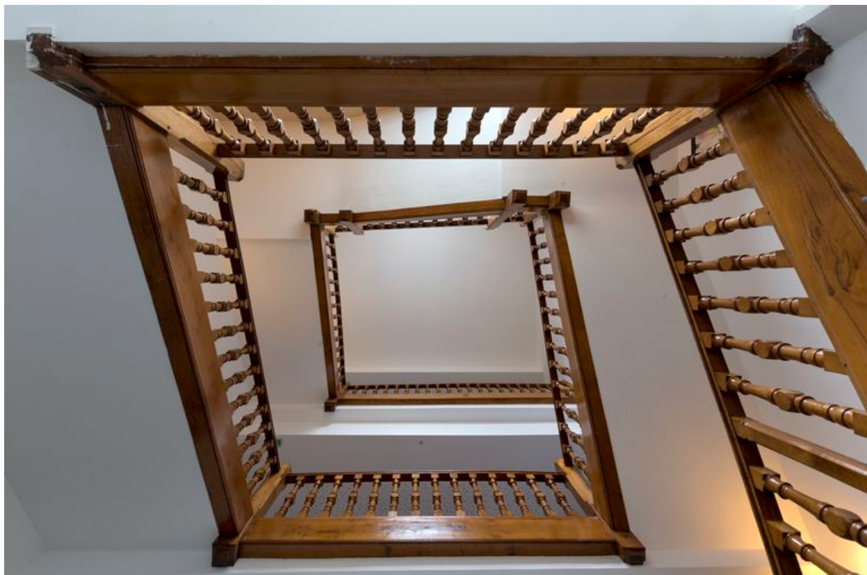
3 : escalier rampe sur rampe.
