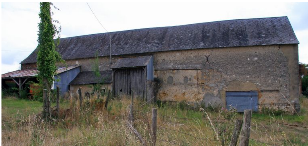
La grange : façade postérieure.
