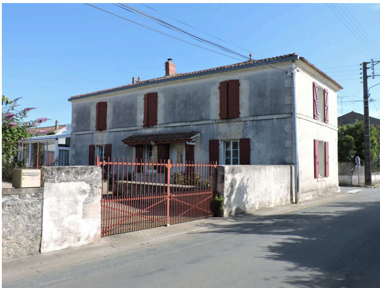
Le logis vu depuis le sud.
