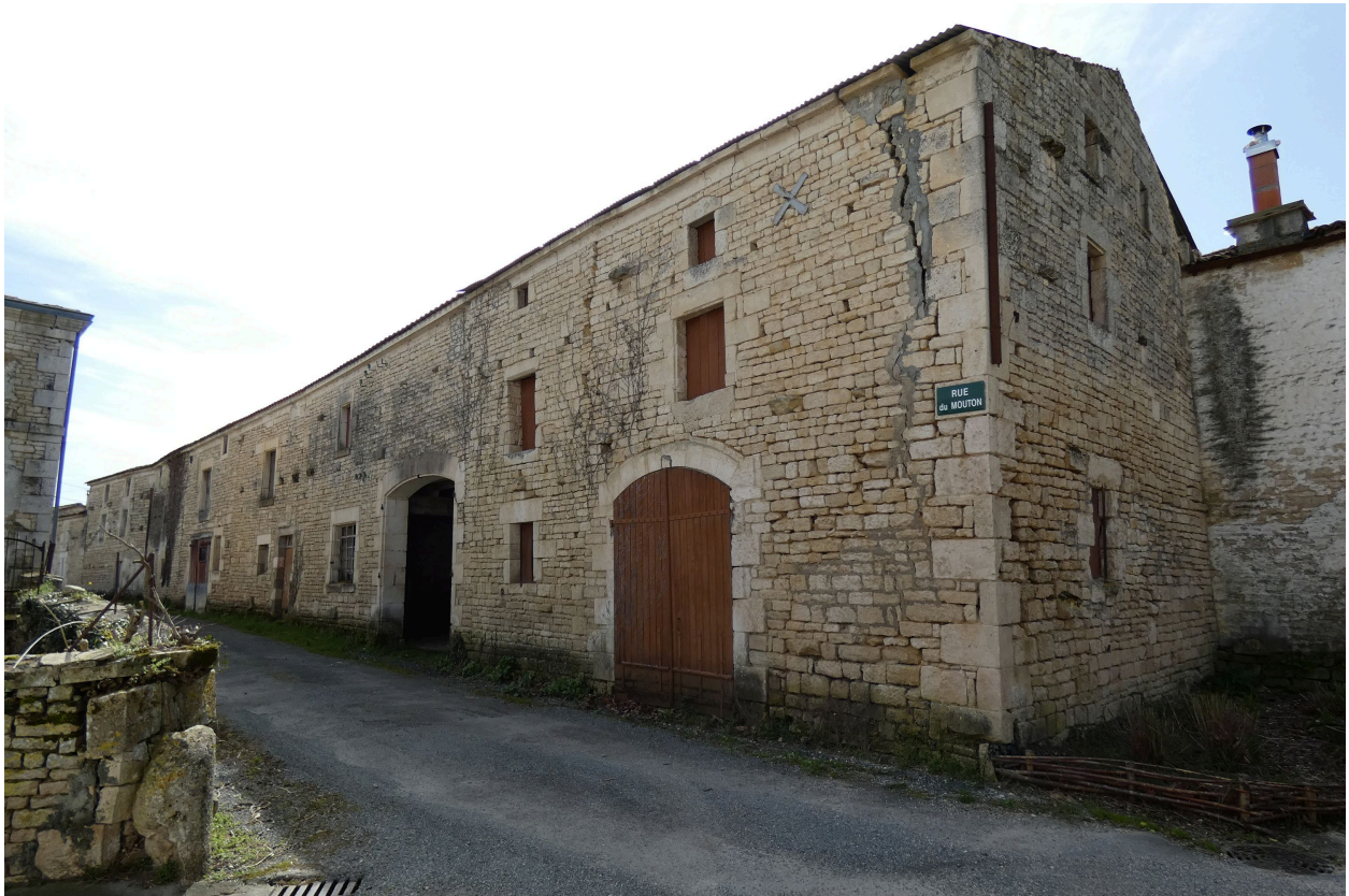
La maison devenue une dépendance vue depuis le nord.
