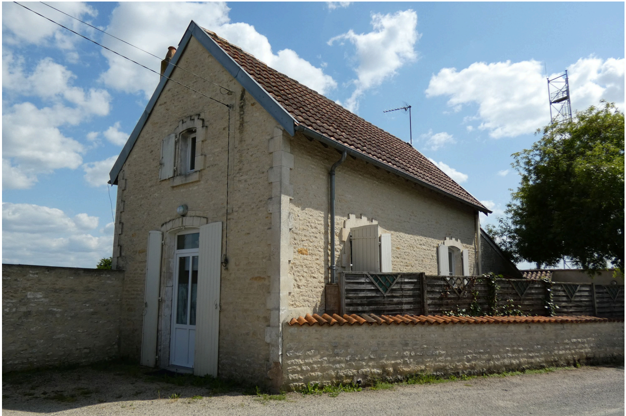
Le logement de gardien vu depuis le nord.
