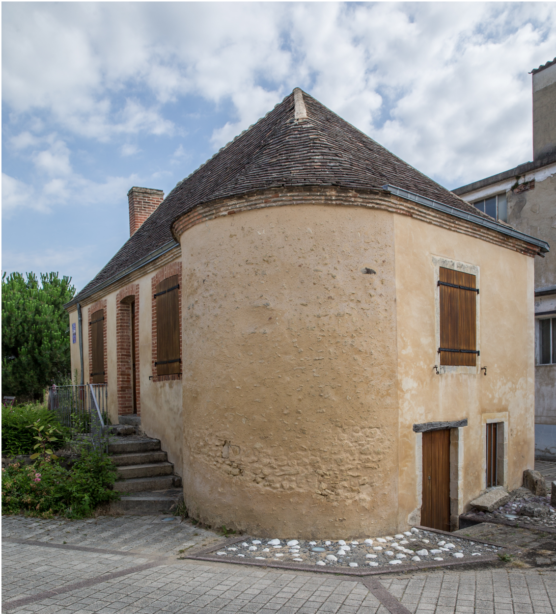
La tour de la Gaillarderie et la maison accolée.
