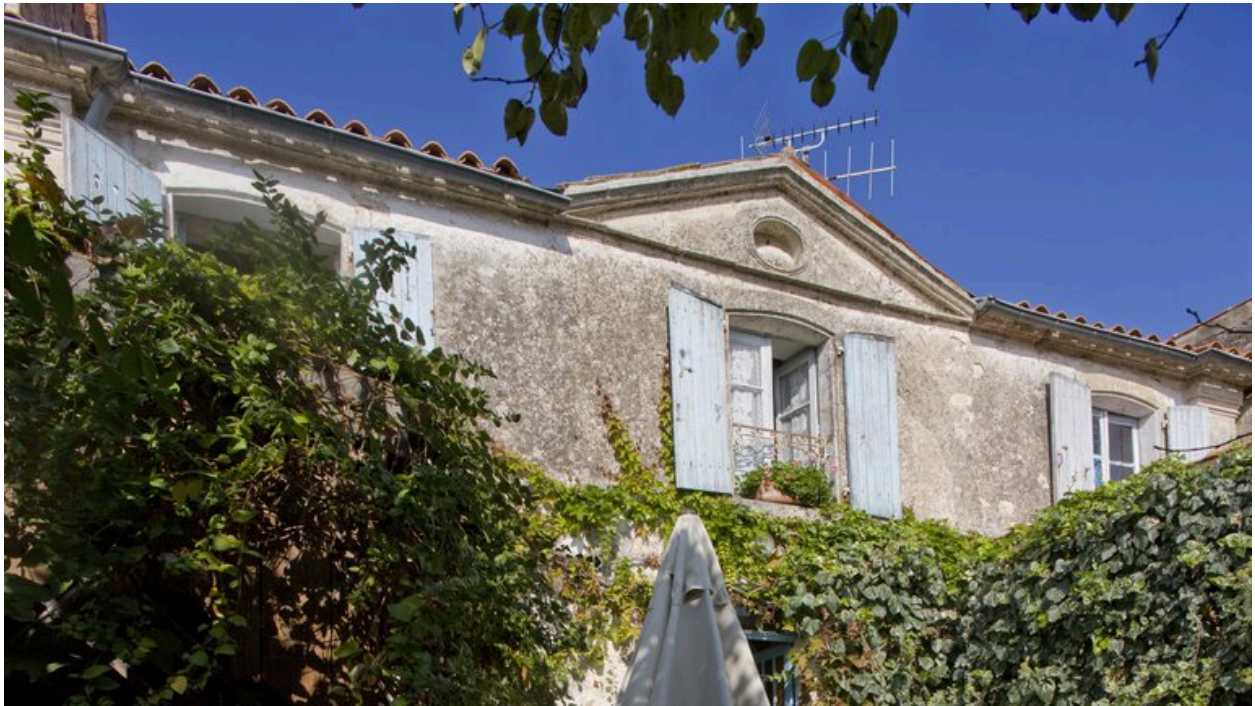
Partie supérieure de la façade sur cour.
