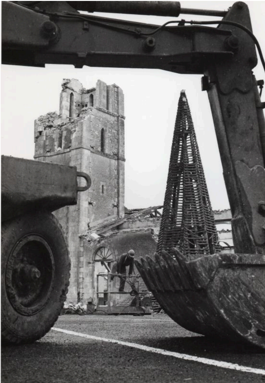
La démolition du clocher en janvier 1974.
