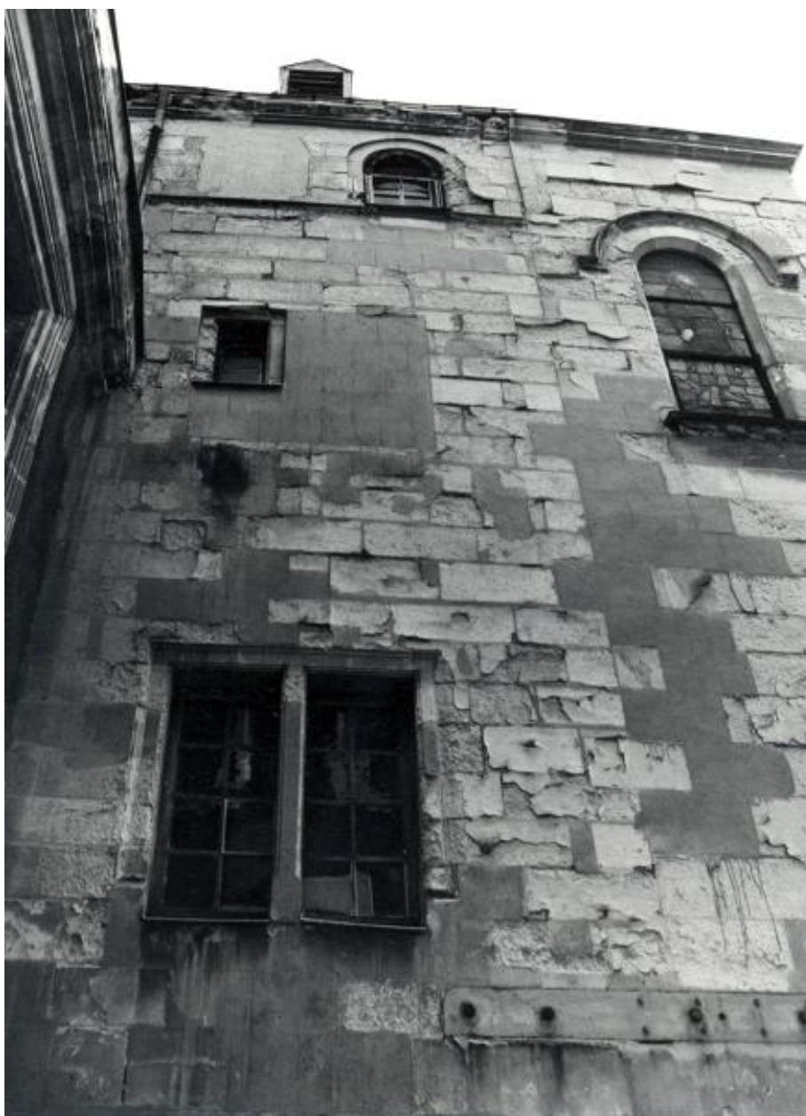
Corps d'escalier 16e s., à la jonction du logis principal 12e s. et du logis sud-ouest : élévation sur cour.
