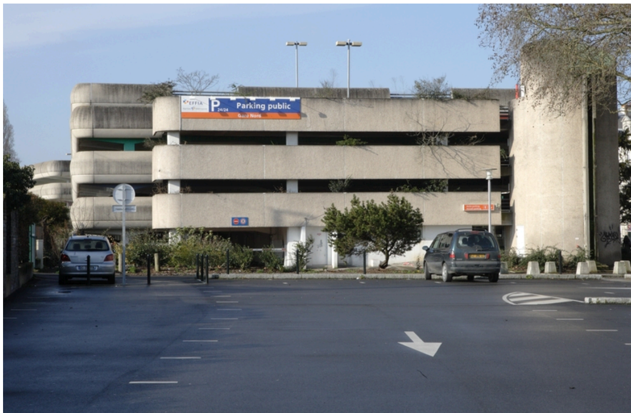
Parking, accès nord.
