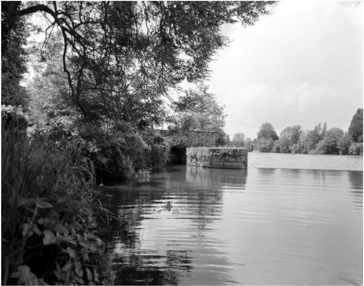
Vestiges du moulin : le soubassement et le coursier du large, vus d'amont.
