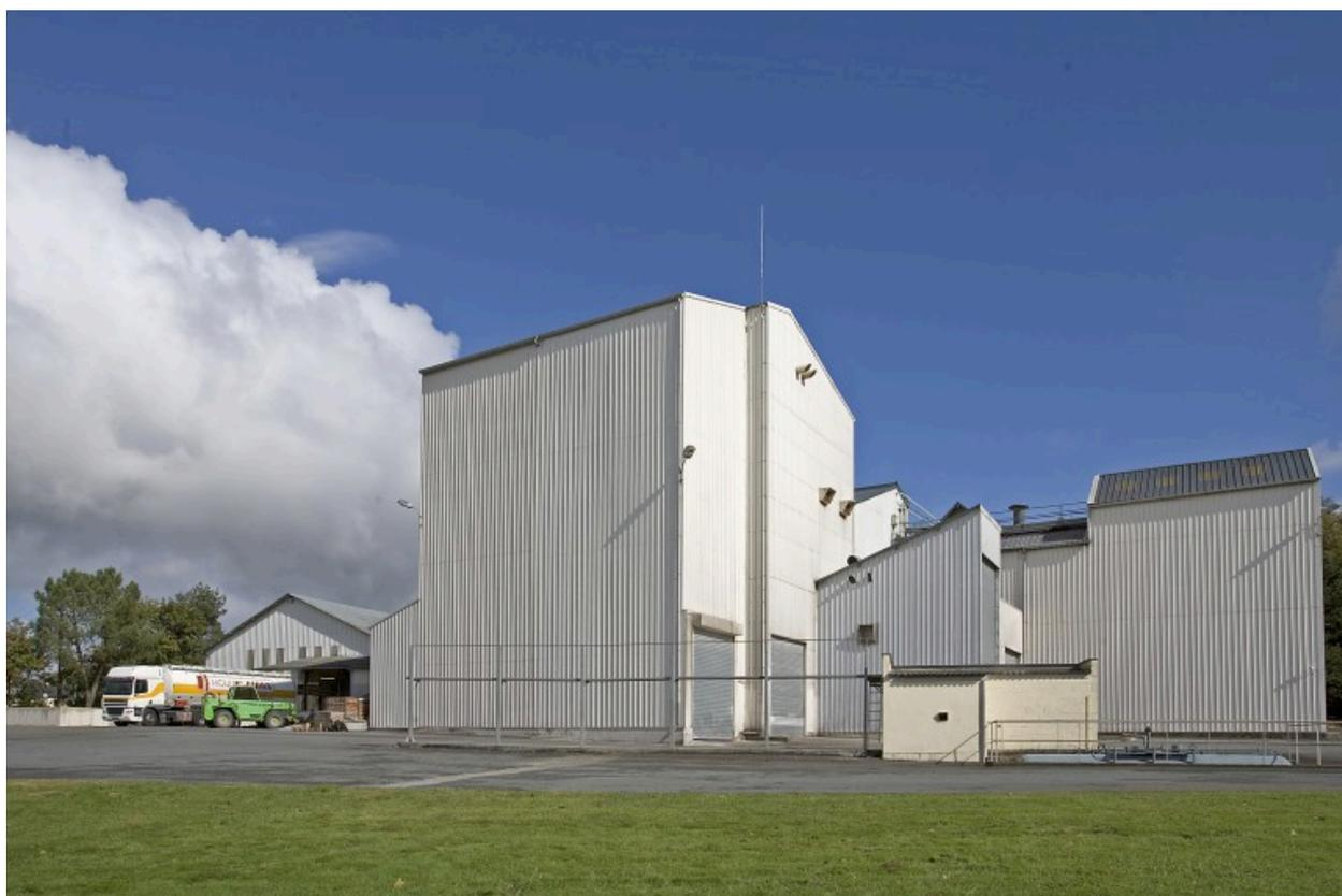
Vue d'ensemble depuis le sud. De gauche à droite : le bâtiment de stockage des sacs de farine ; le bâtiment abritant le poste d'expédition du son et du remoulage, le poste d'expédition de la farine en vrac et les silos à farine ; la fosse de réception ; le bâtiment abritant les silos à blé.
