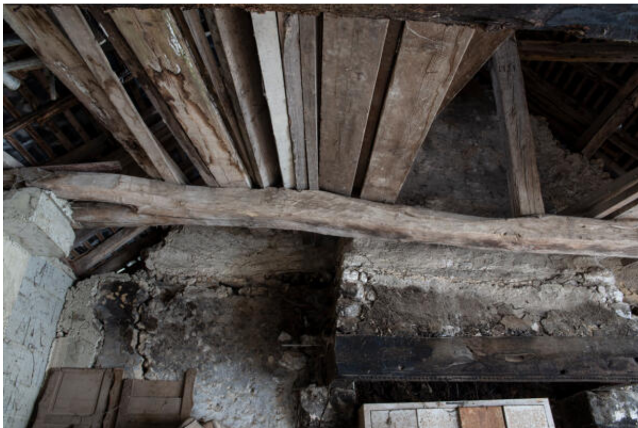
Ancien logis de la ferme des Guénardières, actuellement garage (cadastre 2024 C 247) : entrait de charpente taillée dans un bois de haie fourchu.
