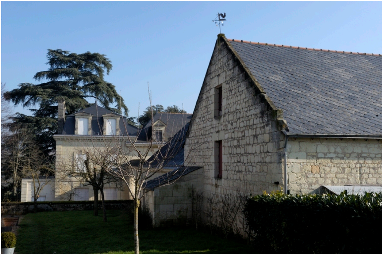
Extrémités ouest du logis et des dépendances.
