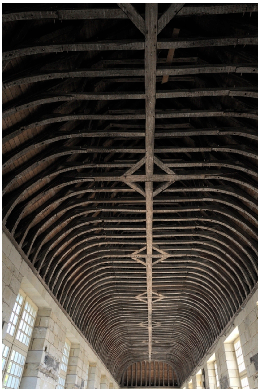
Galerie, intérieur. Vue de la charpente (datée par dendrochronologie de 1676-1680).
