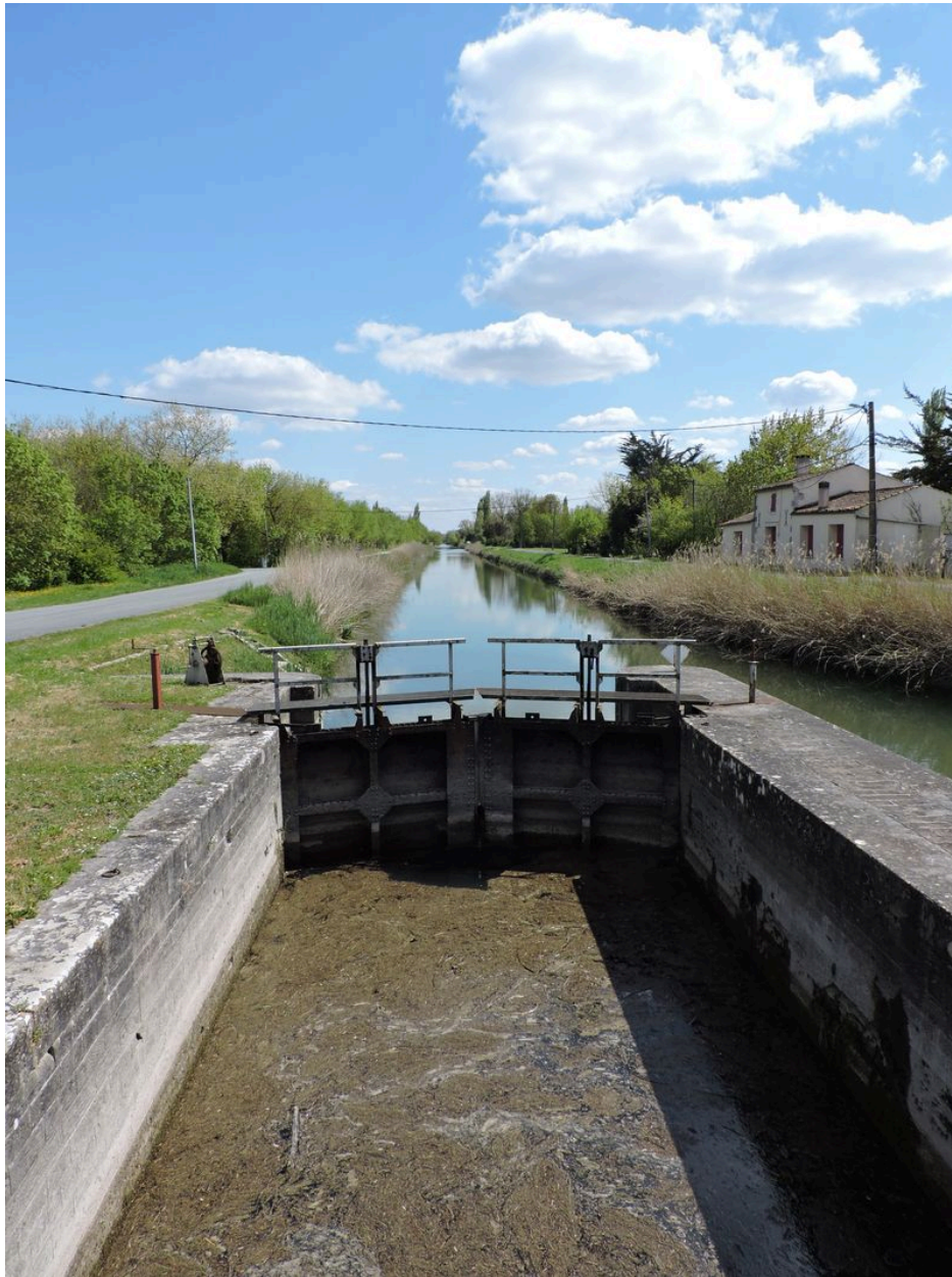
Le sas et la porte amont de l'écluse, en direction de l'amont et du sud-est.
