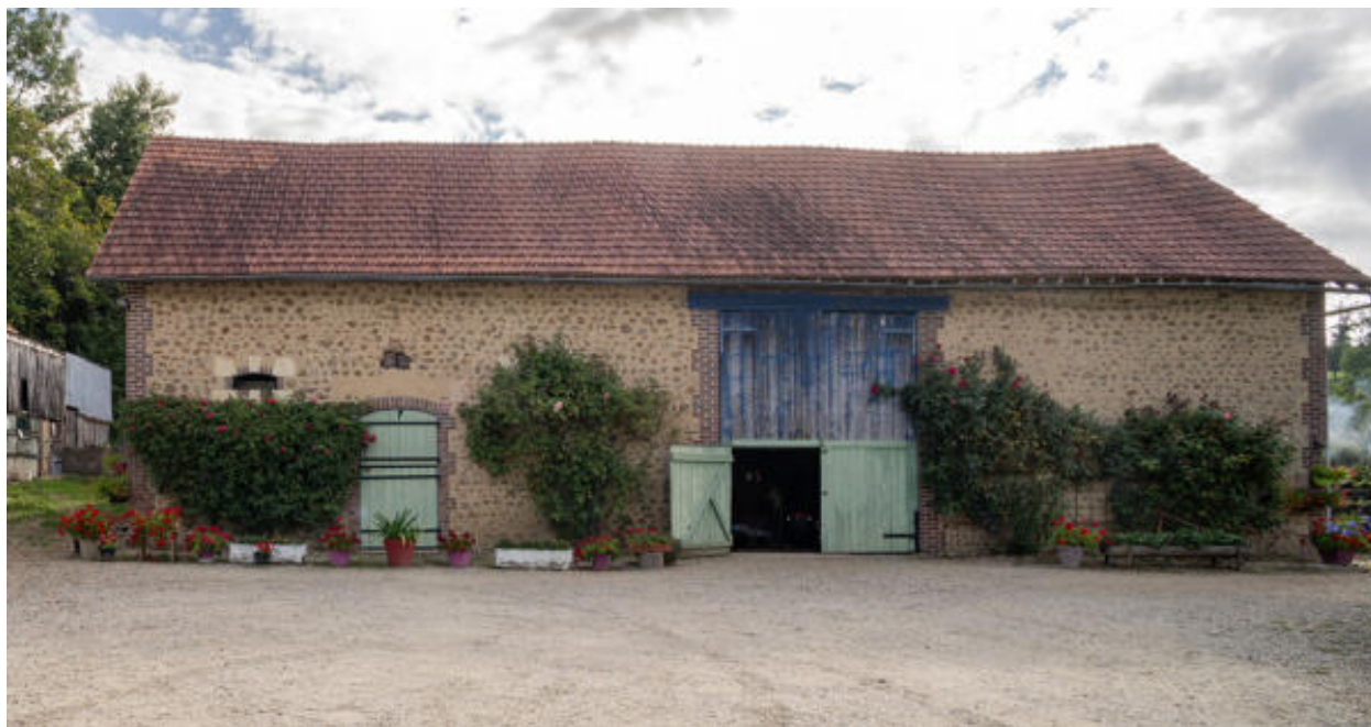
Grange-étable, vue de face.
