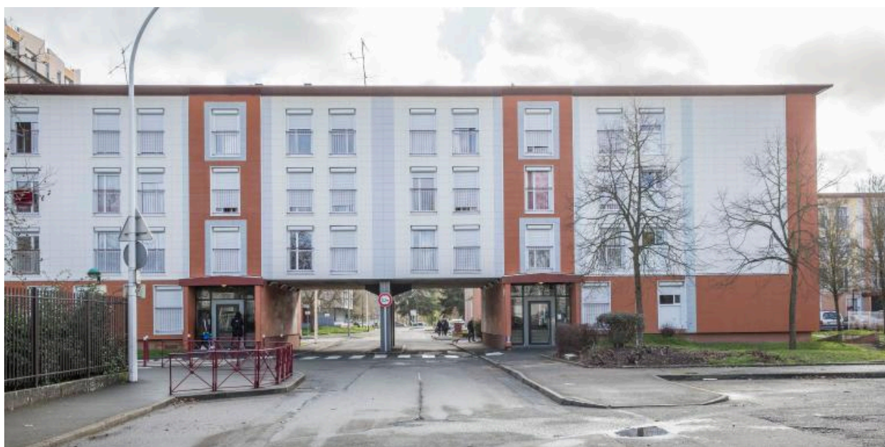
Vue du passage en rez-de-chaussée d'une barre partie est.
