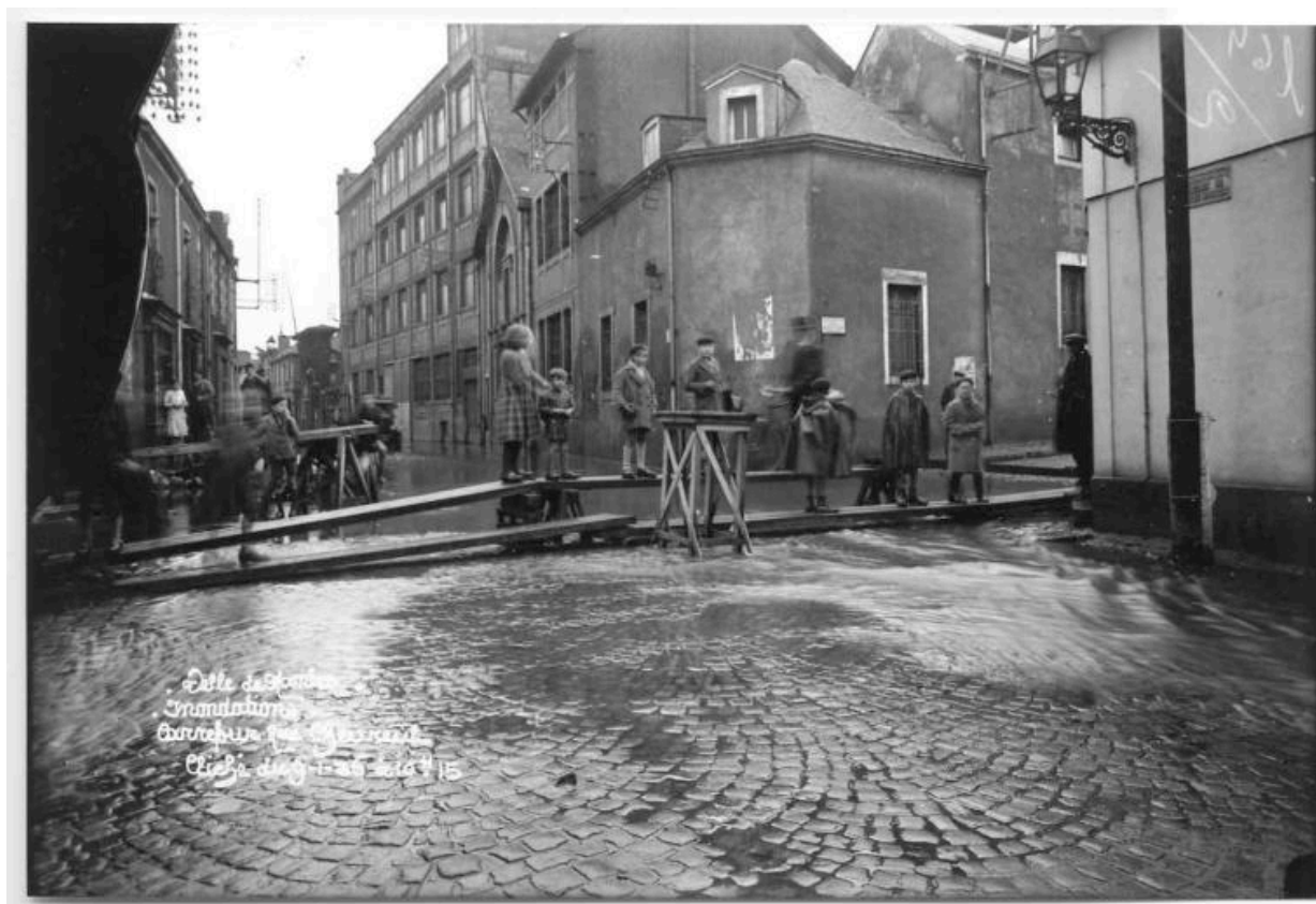
Façade nord de l'usine Amieux, carrefour de la rue Chevreul, du chemin de Roche-Maurice, de la rue de Réaumur et de la rue Jules Verne, 1936.
