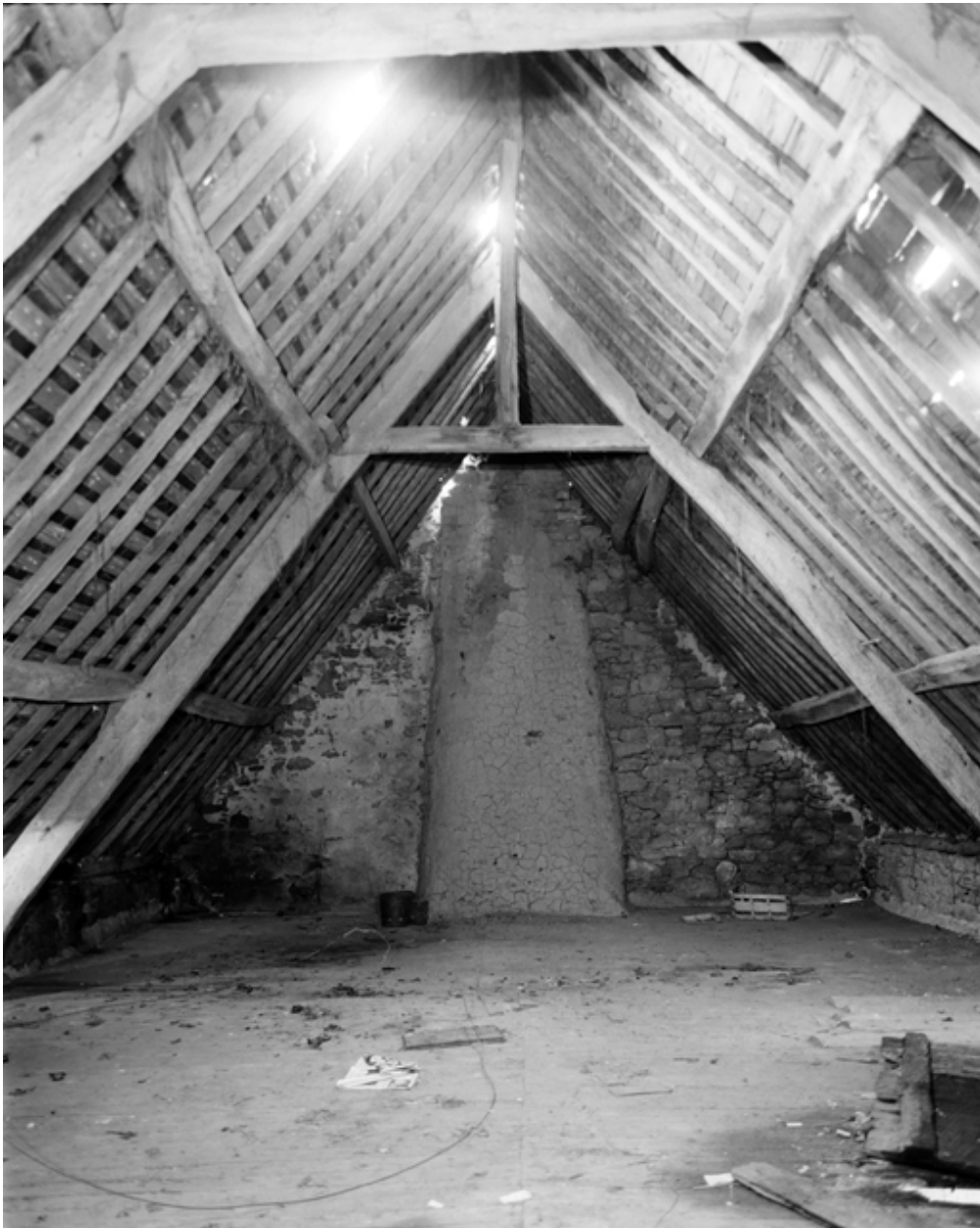
Vue de la charpente. État en 1992.
