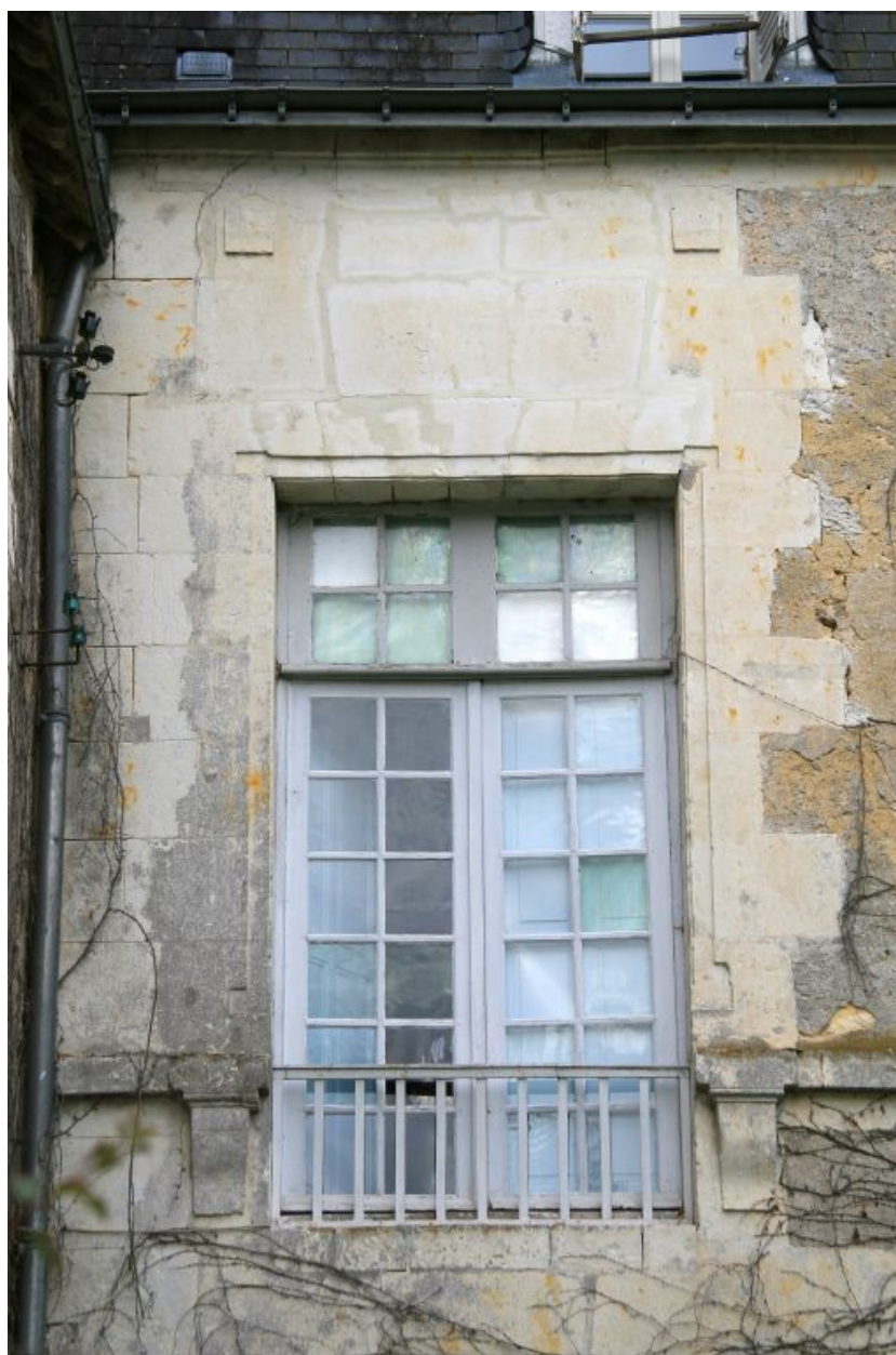
Aile nord, face est, détail : baie du XVII e siècle (?).
