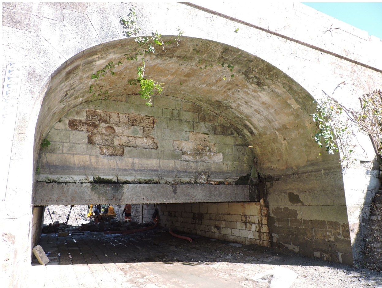
Août 2020 : l'aqueduc vu depuis l'aval.
