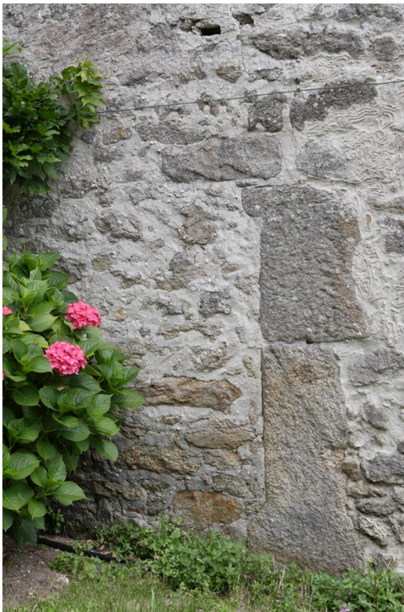
Métairie. Vestiges de la cheminée sur le mur pignon ouest.
