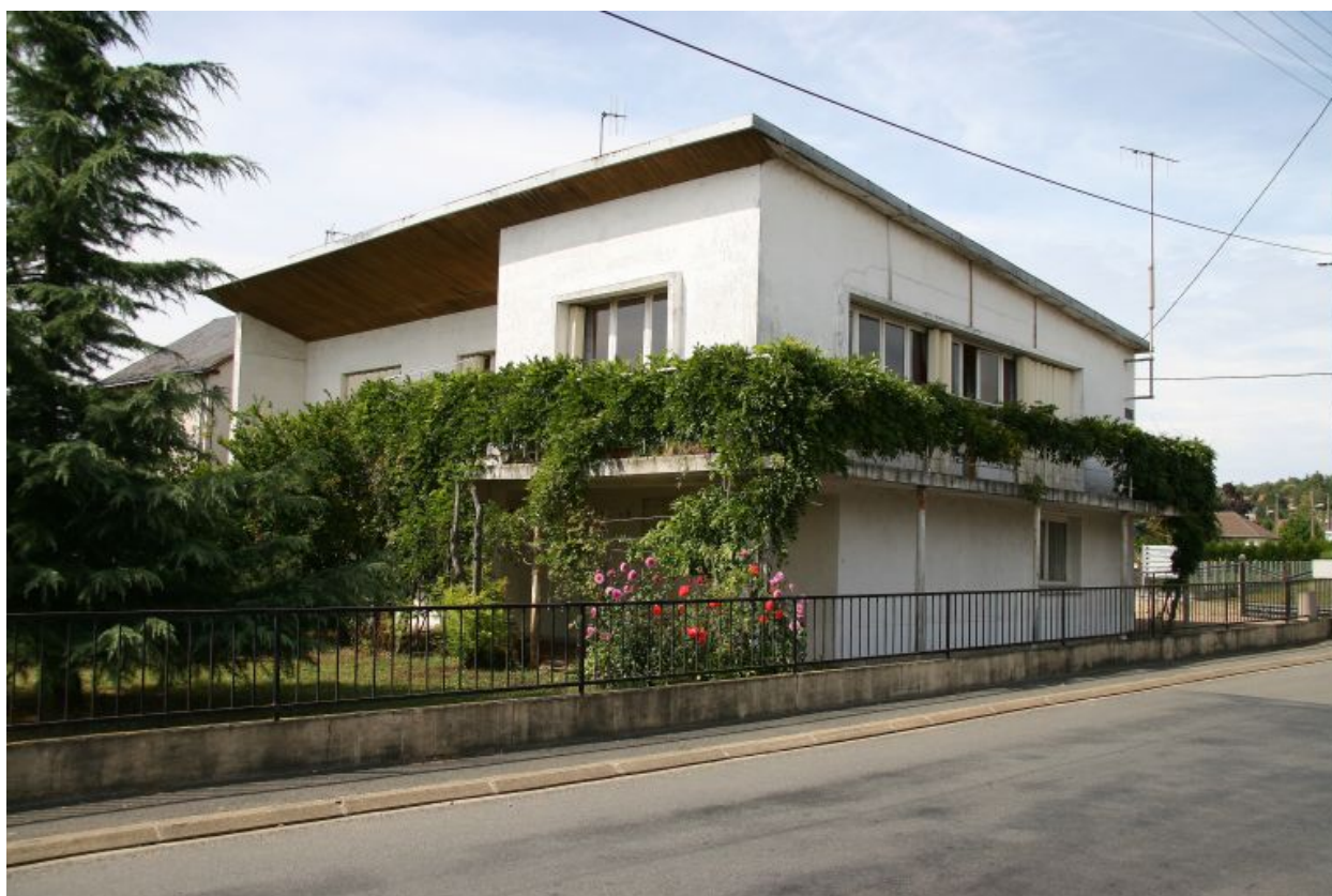
Vue de volume : façade sur rue et façade sur le jardin.
